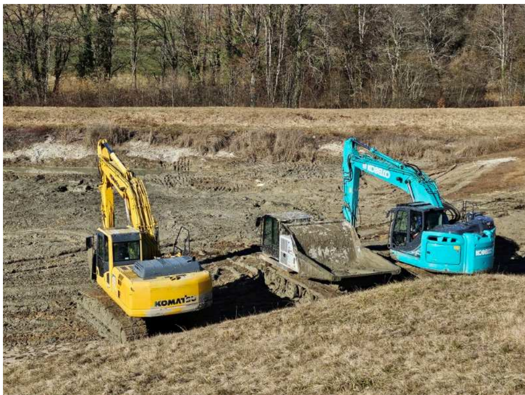
Photo 2 - Travaux de curage après vidange de l'étang le 02/02/2024
