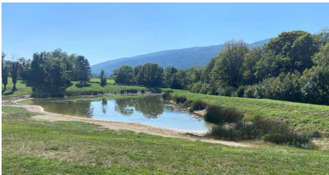
Photo 1 - Etang de la Vendrolière avant travaux le 11/09/2023
